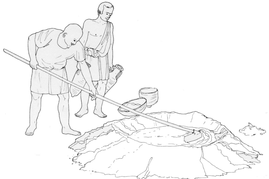
Préparation du mortier de chaux ou corroyage ; mélange du sable, de la chaux grasse et de l'eau, à l'aide du rabot. JPA.
